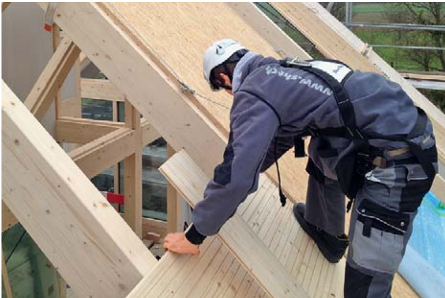
Les dispositifs antichute sont mis en place à l'atelier de montage.
