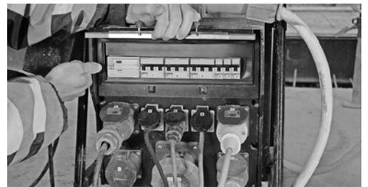
7 Steckdosenverteiler mit Fehlerstrom-Schutz-einrichtung (FI-Schutz/RCD). Funktionsfähigkeit des FI-Schutzes prüfen vor dem Arbeitseinsatz, gemäss Herstellerangaben.
