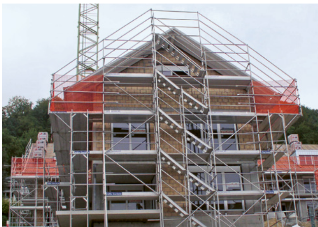
3 Fassadengerüst mit korrekt erstelltem Treppenturm
