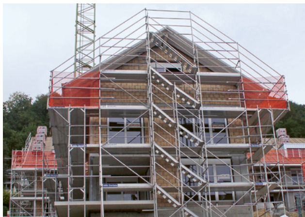
3 Fassadengerüst mit korrekt erstelltem Treppenturm
