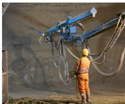
2 Utiliser si possible un manipulateur, se tenir dans la zone déjà consolidée.
