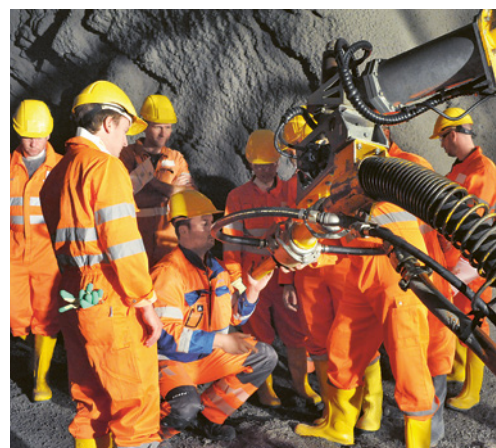
5 Les machinistes sont instruits sur le maniement de la machine à projeter le béton.
