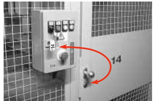
Bild 1: Schlüsselkonzept: Der Zutritt in Fahrgasse 14 ist nur mit dem zugehörigen Schlüssel möglich. Dieser kann am Steuerkasten nur in der Aus-Position abgezogen werden, also bei abgeschaltetem Regalbediengerät. Im Bild ist das entsprechende Schlüsselpaar untrennbar miteinander verbunden. Die Türe hat aussen einen Knauf (lässt sich also nur mit Schlüssel öffnen) und innen einen Türdrücker (Flucht ohne Schlüssel möglich).
