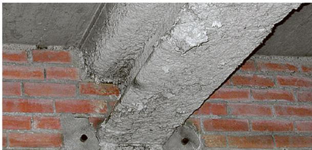
Amiante floqué sur poutre métallique
