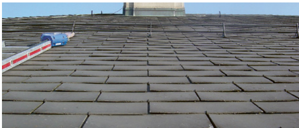
Toit en ardoises
