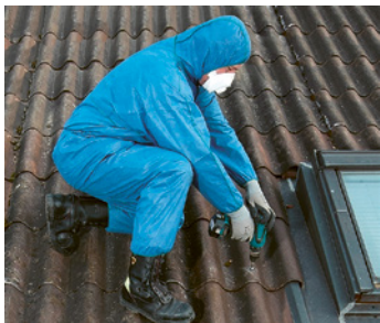
Remplacement de fenêtres de toit
