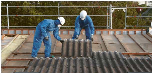
Démantèlement de plaques ondulées
