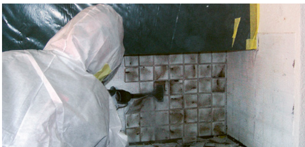
Enlèvement par une entreprise de désamiantage reconnue
