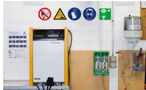
**3** Station de recharge des batteries réglementaire avec interdiction de fumer. Des lunettes de protection et une douche oculaire sont à disposition.
