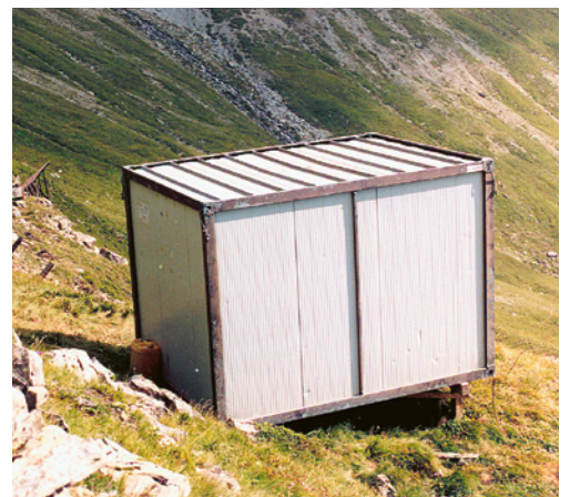
5 Dieser Container ist gegen Blitzschlag gesichert. Er befindet sich an einem sicheren Ort in unmittelbarer Nähe des Arbeitsplatzes.
