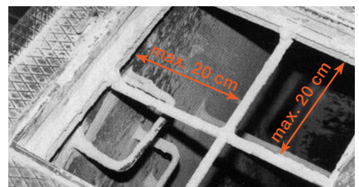
5 Der Zutritt wird mit einem verschraubten Gitter verwehrt.
