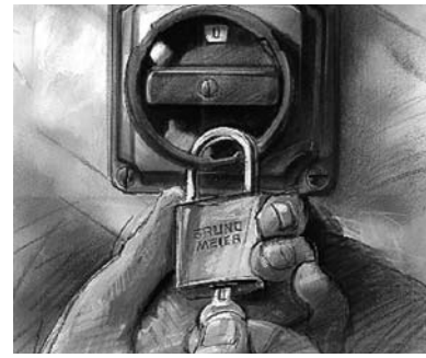
8 Sicherheitsschalter, in der Nullstellung mit Vorhängeschloss abschliessbar.
