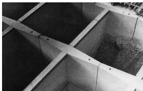
4 Soluzione migliore per limitare l'accesso: silo senza scala fissa
