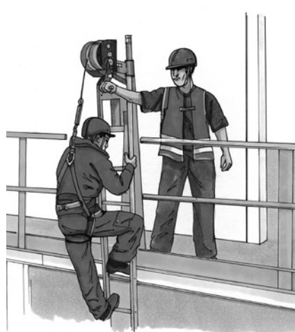
12 Accesso al silo tramite scala. Permessi solo in combinazione con un dispositivo anticaduta di tipo retrattile con dispositivo di salvataggio.
