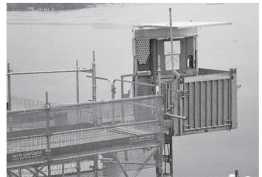
Fig. 4: accès sûr à la plateforme d'un ascenseur de chantier
