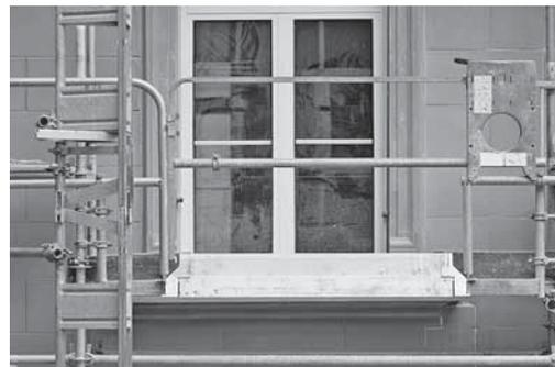
Fig. 1: palier avec portillon verrouillable
