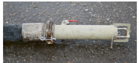
9 Durante l'espulsione mediante aria è indispensabile utilizzare il cestello di trattenuta.
