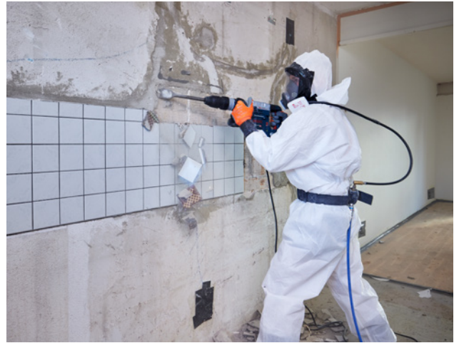
1 Schutzmassnahmen gemäss EKAS-Richtlinie 6503 «Asbest».
