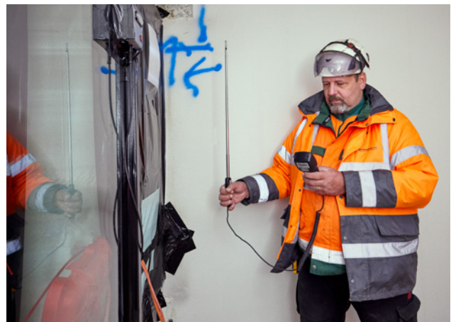
2 Überprüfung der wirkungsvollen Durchlüftung der Sanierungszone.
