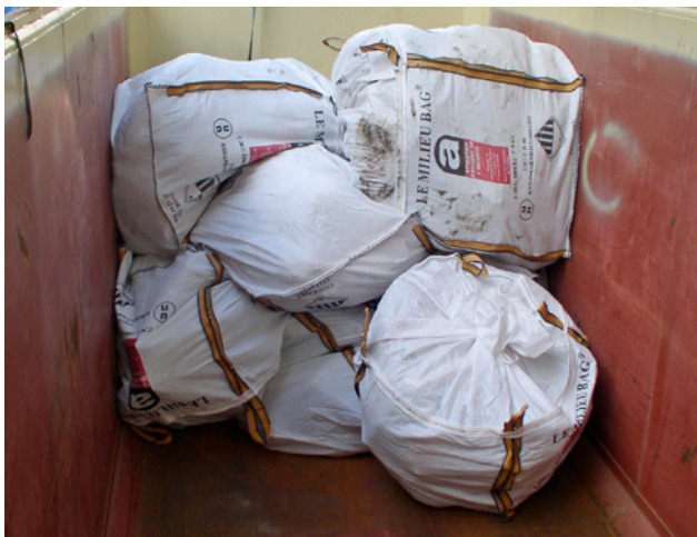
3 Asbesthaltiger Abfall muss gesondert entsorgt werden.
