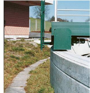
**15** Grâce à l'abaissement du terrain, le mur du bassin atteint 110 cm de hauteur et sert de protection contre les chutes.
