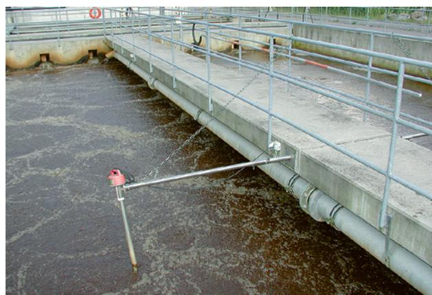
**35** Il est possible de tirer jusqu'au bord du bassin d'aération les sondes de mesure au moyen d'un câble, d'où une maintenance en toute sécurité des sondes.
