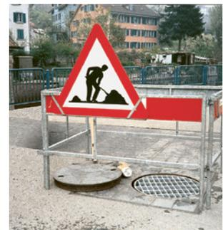
**18** Les dispositifs mobiles permettant de sécuriser les ouvertures dans le sol doivent toujours être installés avant l'enlèvement de la couverture.
