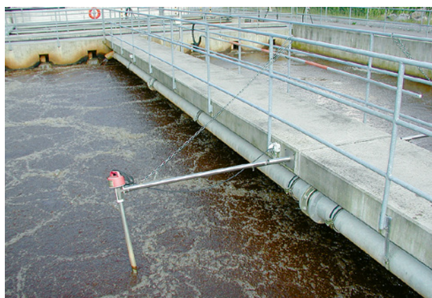
35 Il est possible de tirer jusqu'au bord du bassin d'aération les sondes de mesure au moyen d'un câble, d'où une maintenance en toute sécurité des sondes.
