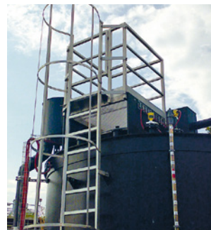
25 et 26 Échelle verticale avec protection dorsale et palier intermédiaire. L'échelle verticale est sécurisée avec une porte à fermeture automatique, la bordure du toit protégée par un garde-corps.
