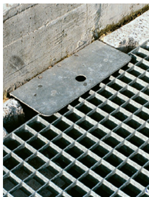
19 et 20 L'évidement de la grille peut être obturé au moyen d'un clapet s'il n'est pas utilisé.
