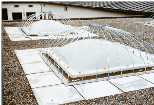
28 Treillis métallique empêchant que le lanterneau peu résistant se brise.
