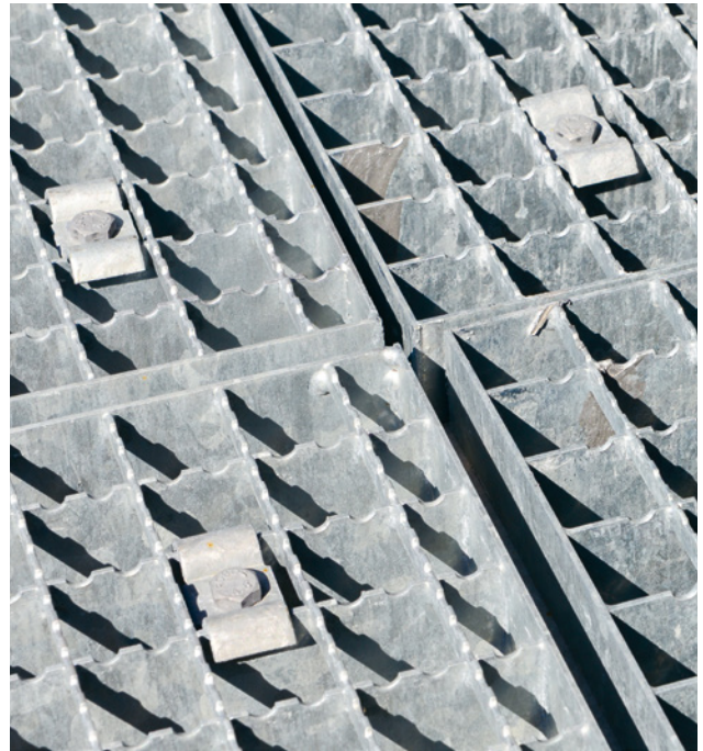
10 Chaque élément de la grille est fixé de sorte à empêcher tout déplacement involontaire.
