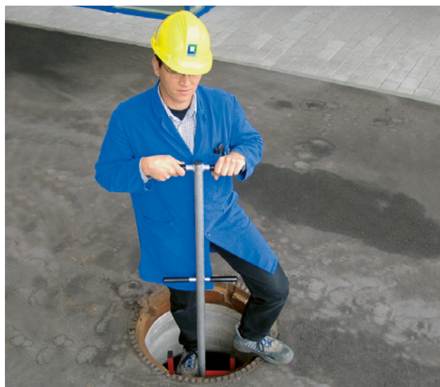
27 Utilisation d'une canne pour descendre dans un regard de visite (longueur min. de la canne 1 m).
