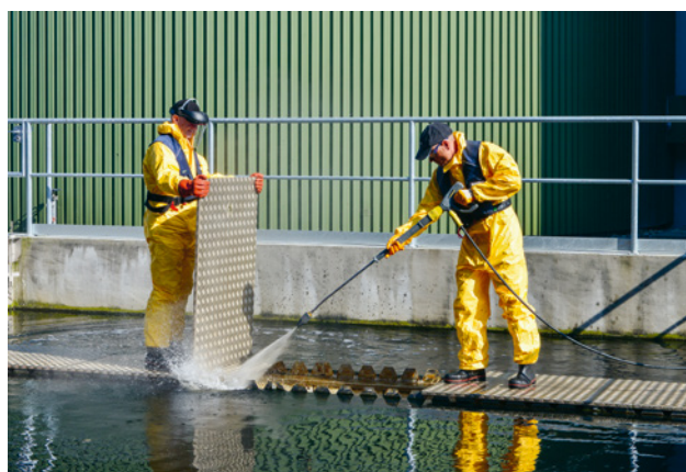
33 Port du gilet de sauvetage en cas de travaux hors de la zone sécurisée près des bassins remplis d'eau.
