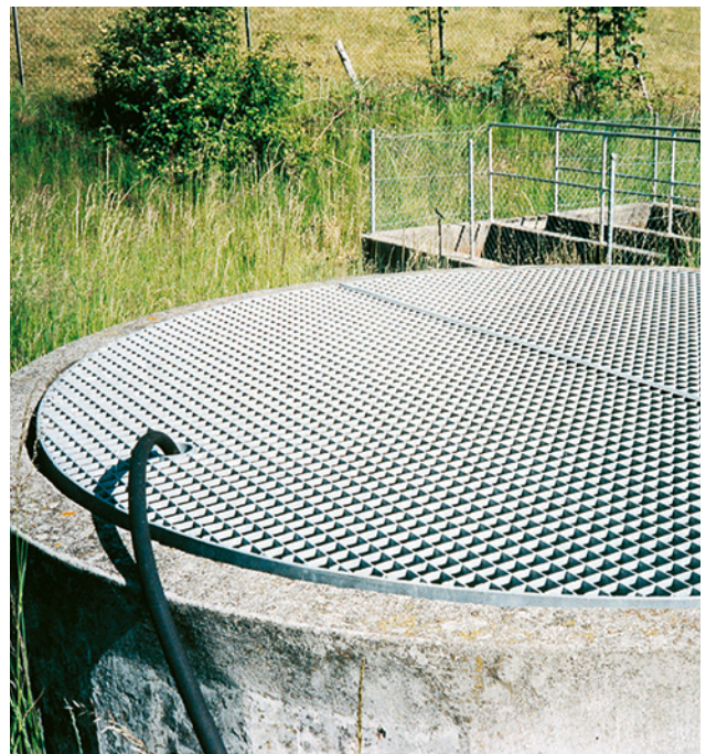
12 Les grilles et les couvertures doivent être fabriquées dans un matériau résistant tel que matière synthétique ou acier.
