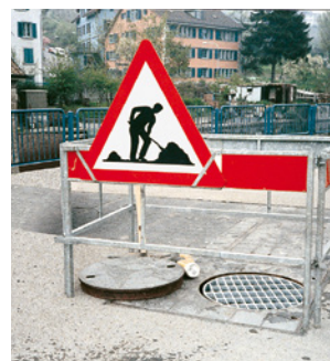
18 Les dispositifs mobiles permettant de sécuriser les ouvertures dans le sol doivent toujours être installés avant l'enlèvement de la couverture.
