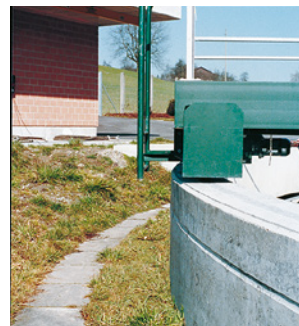
15 Grâce à l'abaissement du terrain, le mur du bassin atteint 110 cm de hauteur et sert de protection contre les chutes.
