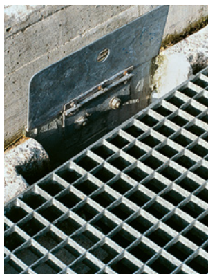
19 et 20 L'évidement de la grille peut être obturé au moyen d'un clapet s'il n'est pas utilisé.
