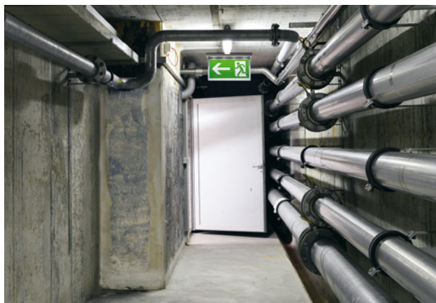
29 Chemin de fuite signalisé correctement.
