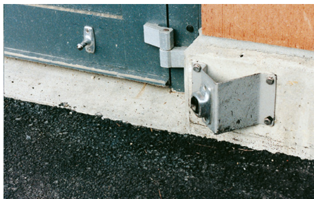
23 Le dispositif de protection contre l'effet du vent installé près de cette porte ne fait courir aucun risque de faux pas, car il est fixé au mur.
