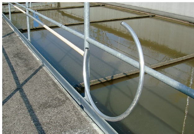
32 Perche de sauvetage, de préférence insubmersible, avec crochet %.
