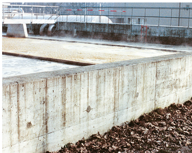
16 Mur d'un bassin relevé à une hauteur minimale de 110 cm au-dessus du niveau du terrain.
