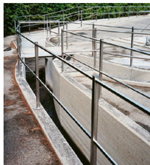
14 Garde-corps installé le long des bords donnant sur le vide pour sécuriser les canaux ouverts.
