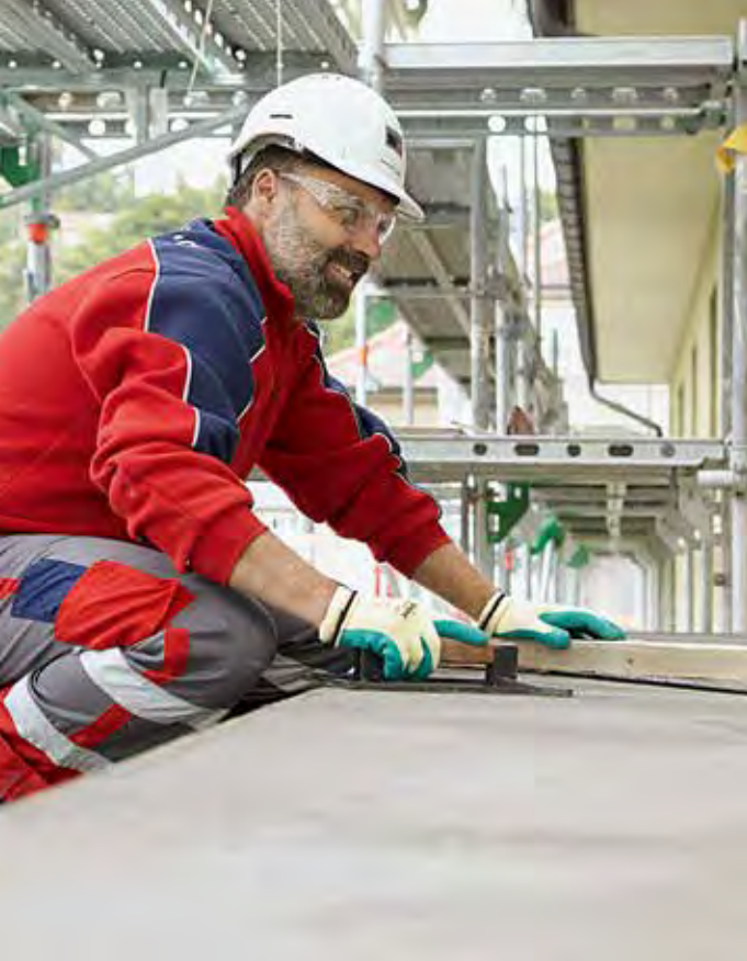
Jede Baustelle wird einmal pro Monat auditiert. Dazu gehört auch das Notfalldispositiv.
