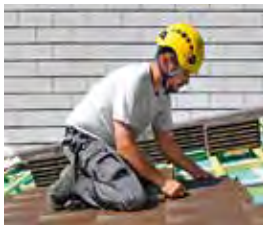
Dächer und Fassaden
