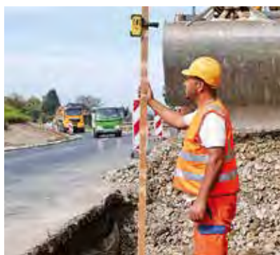
Verkehrsweg- und Tiefbau
