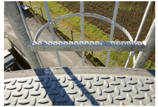
4 Échelons antidérapants. L'échelon supérieur est à la hauteur du point de sortie.
