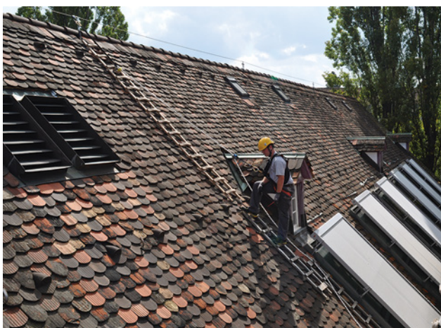
28 I sistemi di posizionamento sul posto di lavoro sono dispositivi di protezione individuale che permettono alla persona, appoggiandosi al sistema, di assumere una posizione di lavoro in cui viene impedita la caduta tramite il cordino.
