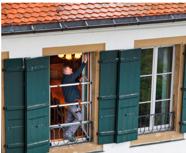
19 Il dispositivo di sicurezza per finestre consente all'addetto alle pulizie di rimanere in piedi sul davanzale senza correre alcun rischio.
