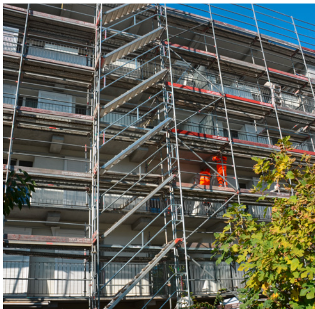
21 Ponteggio per facciata con torre scala
