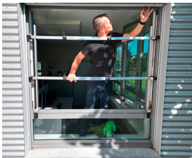
20 I dispositivi di sicurezza mobili per finestre vengono installati all'interno dell'edificio nell'apertura della finestra in modo da creare postazioni di lavoro sicure.
