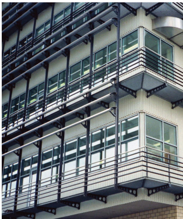
1 Balconi con parapetti che permettono la pulizia esterna delle finestre senza rischi.
