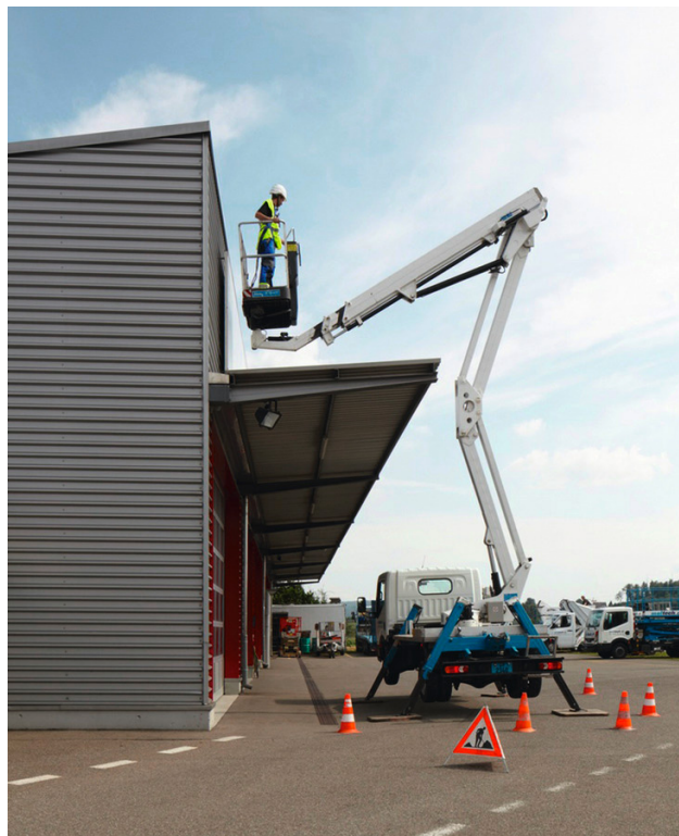
18 Lavori di pulizia e manutenzione con l'ausilio di una piattaforma di lavoro elevabile.
