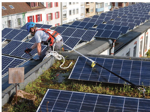
29 I sistemi di arresto caduta sono dispositivi di protezione individuale che arrestano la caduta della persona e limitano l'energia cinetica sviluppata (urto di arresto).
