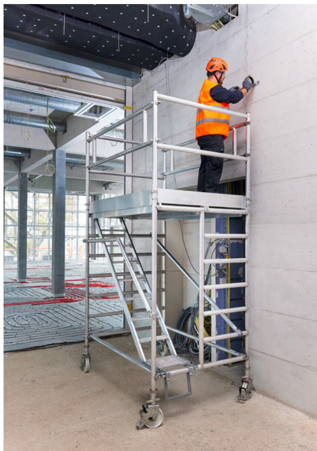
22 Lavori eseguiti da un ponteggio mobile su ruote.
