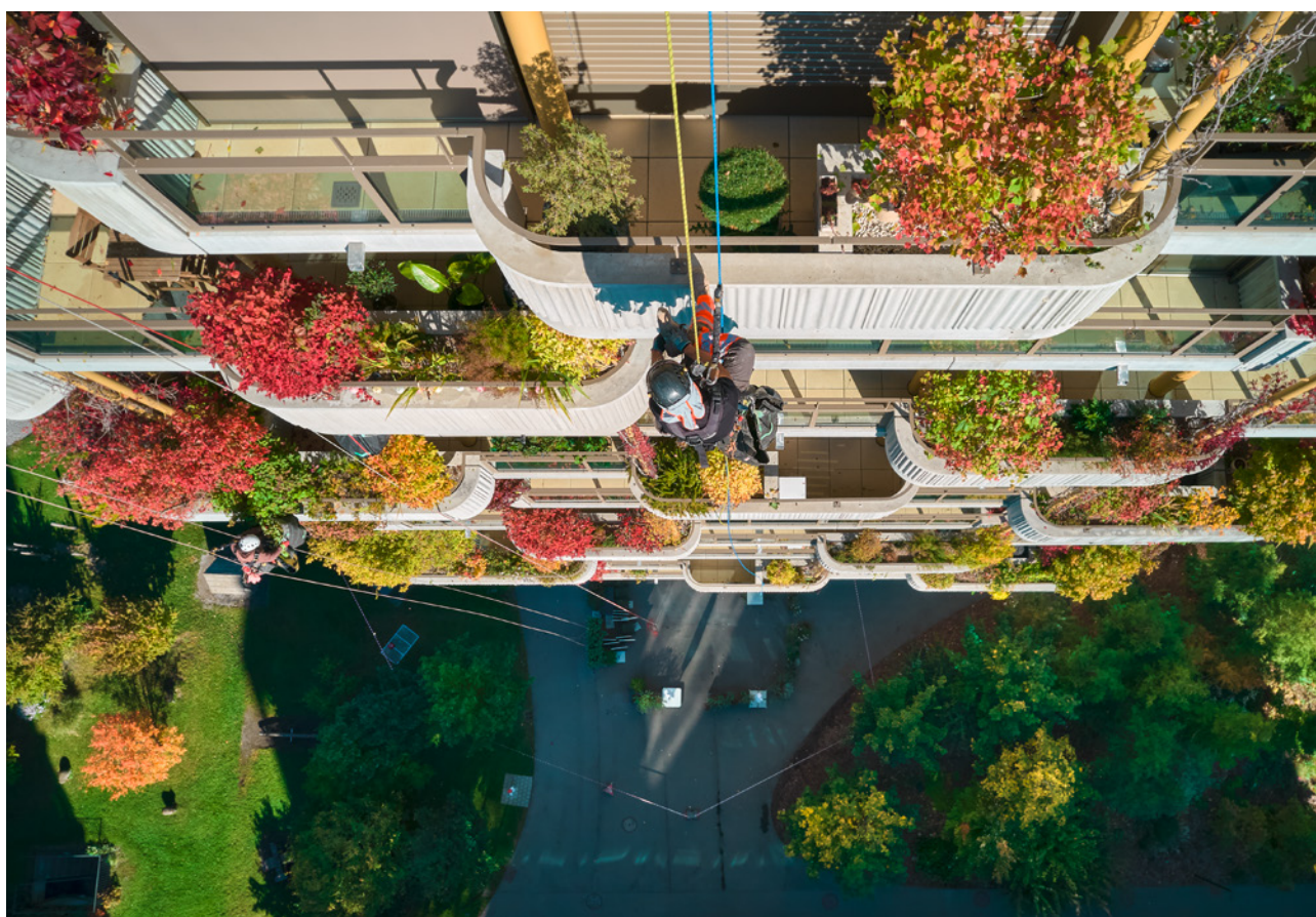
30 Lavori di pulizia e manutenzione in sospensione a corde portanti. Il lavoratore è messo in sicurezza con due funi ancorate separatamente.
