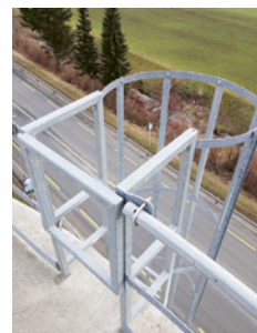
4 Échelle à crinoline équipée d'un portillon automatique.
