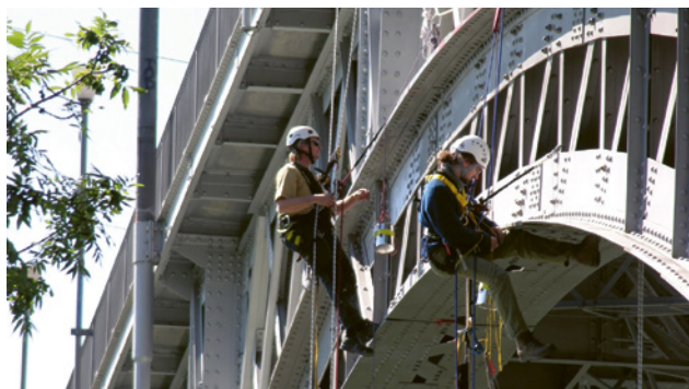
1 I lavori in sospensione a corde portanti devono sempre essere eseguiti con una fune di lavoro e una fune di sicurezza.
