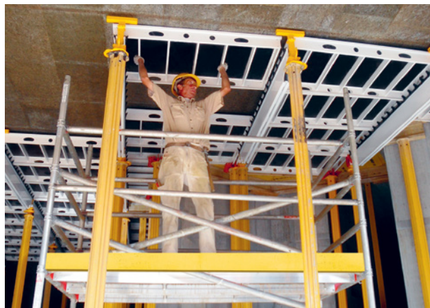
1 Système moderne: coffrage et décoffrage par le bas
