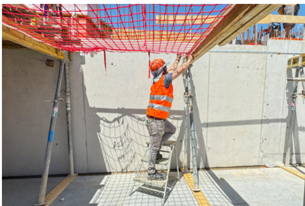
4 Mise en place des filets de sécurité à l'aide d'un escabeau
