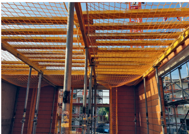
3 Coffrage traditionnel avec protection collective testée et certifiée conforme (filets de sécurité)
