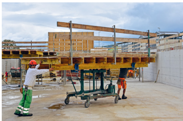
6 Élément de coffrage de dalle avec protection collective prémontée (garde-corps périphérique en trois parties)
