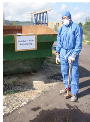
2 Arbeiter mit korrekter Persönlicher Schutzausrüstung
