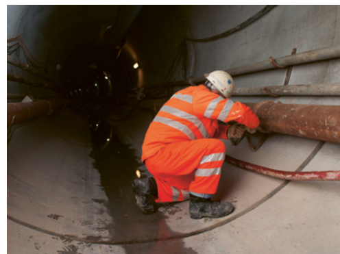
5 Durante i lavori di avanzamento il personale deve essere sempre vigile e pronto a intervenire anche in caso di imprevisti. Ciò comporta attenzione, prudenza e un impegno fisico speciale, ad es. durante gli interventi di manutenzione sulla tratta e sugli impianti di avanzamento.
