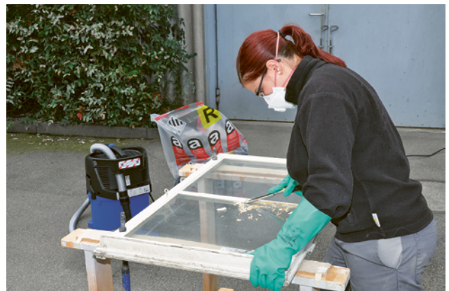
2 Entfernen von asbesthaltigem Fensterkitt mit Stechbeitel oder Spachtel
