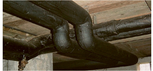
Bitumenbeschichtung
