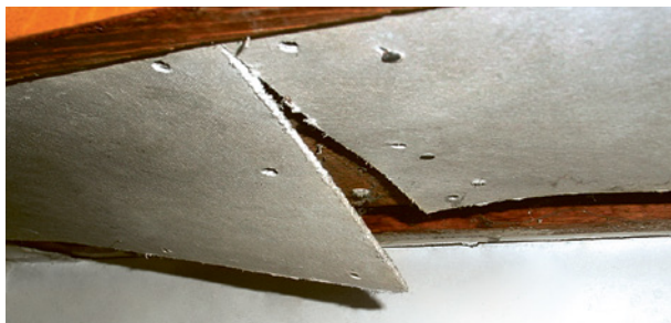
Asbesthaltige Leichtbauplatten
