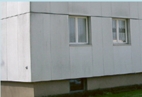
Asbesthaltige Fassadenplatten
