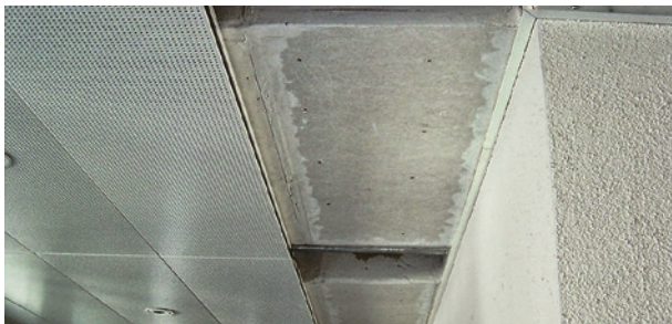
Asbesthaltige Deckenplatten
