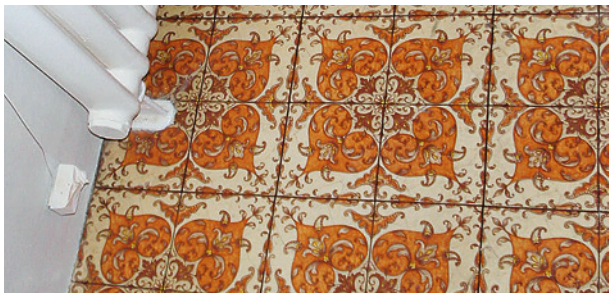
Typisches Muster eines mehrschichtigen asbesthaltigen Bodenbelags
