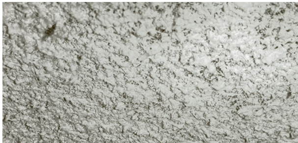
Asbesthaltiger Akustikputz
