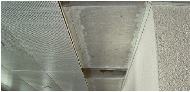
Asbesthaltige Deckenplatten
