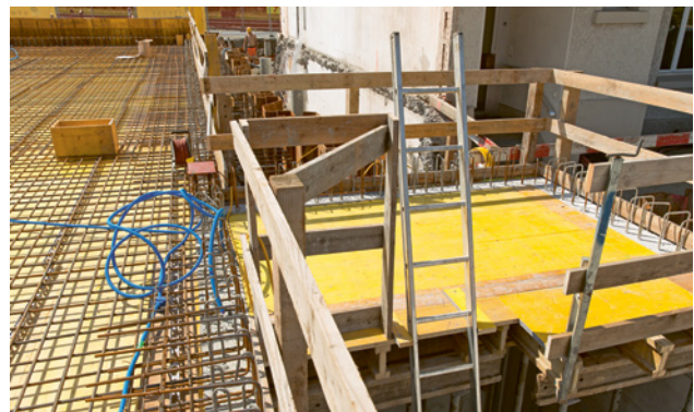
32 Die Leiter ragt mindestens 1 m über die Kante hinaus: Ein sicherer Überstieg ist gewährleistet.
