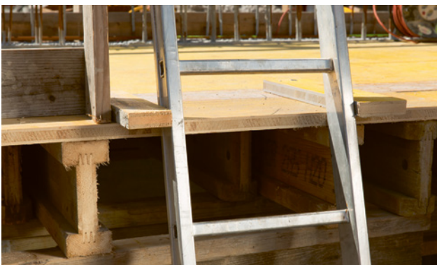
41 Seitliche Führung des Leiterkopfes
