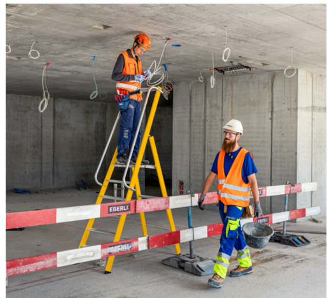
3 Sicherung der Leiter im Verkehrsbereich
