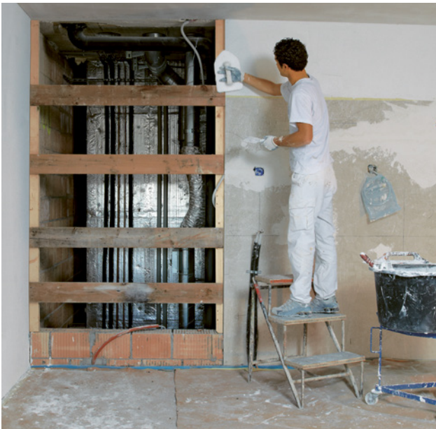
16 Gipser beim Arbeiten an einer Wandöffnung
