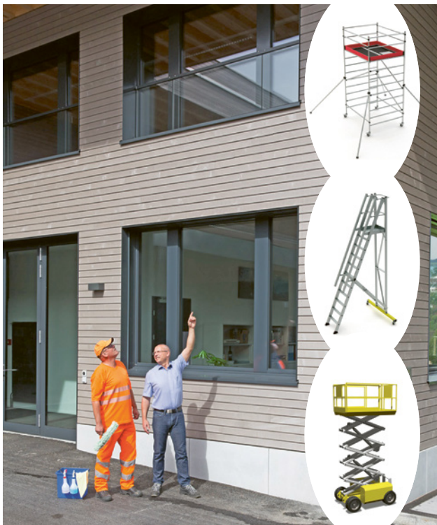
1 Besprechung des Arbeitseinsatzes: Welches Arbeitsmittel ist geeignet?
