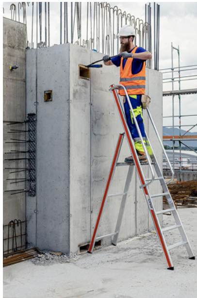
20 Bearbeiten einer Betonwand
