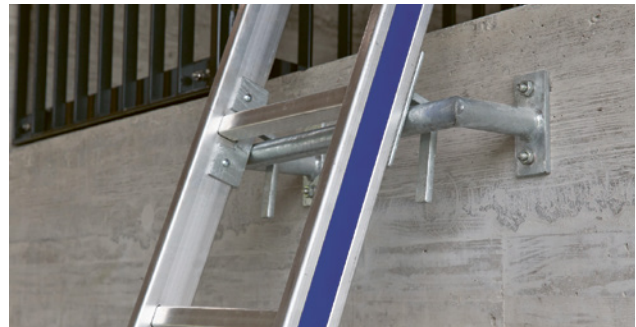
42 Einhängvorrichtung
