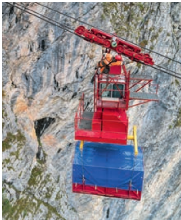
Drohndokumentation bei einer Detailkontrolle am Tragseil auf dem Gehänge der Seilbahn Eggi-Äppigen.
