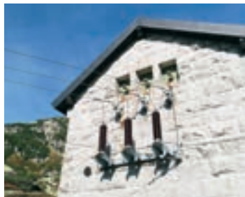
Die Drohne untersucht beispielsweise eine 16kV-Hauseinführung in der Höhe auf allfällige Schäden.
