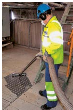
2 Aspiration des dépôts de poussières
