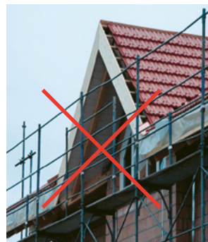
6 und 7 So nicht: unwirksame Dachdeckerschutzwände
