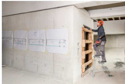
2 Gesicherter Installationsschacht
