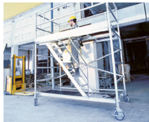
2 Innenaufstieg im Rollgerust
