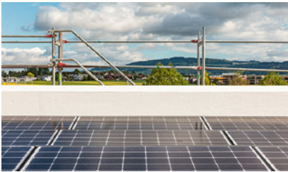
1 Fassadengerüst als Absturzsicherung
