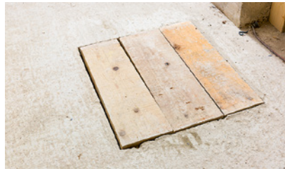
2 Kleine Bodenöffnungen in der Fläche mit eingelegten Brettern
