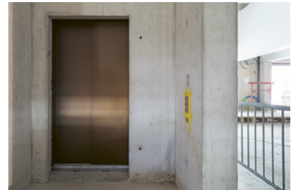
3 Die bereits montierte Lifttür schützt vor einem Absturz
