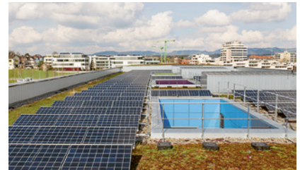
3 Mit Geländer gesicherte Dachöffnungen
