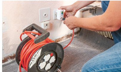
2 Kabelrolle mit mobilem FI-Schutz
