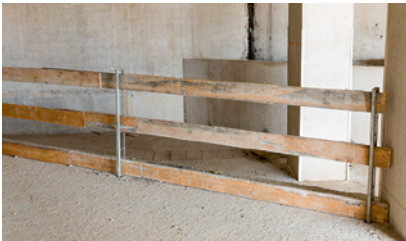
1 Grosse Bodenöffnung mit dreiteiligem Seitenschutz
