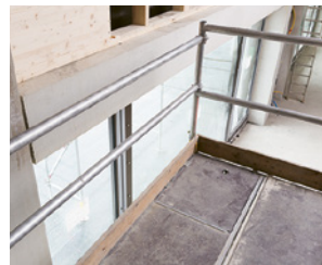
3 Seitenschutz am Rollgerust
