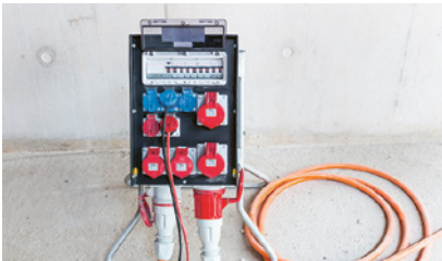
1 Elektrohandwerkzeuge am Baustromverteiler anschliessen.
