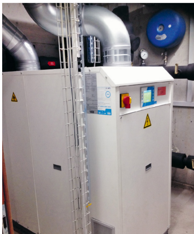
Système frigorifique dans une enceinte ventilée.
