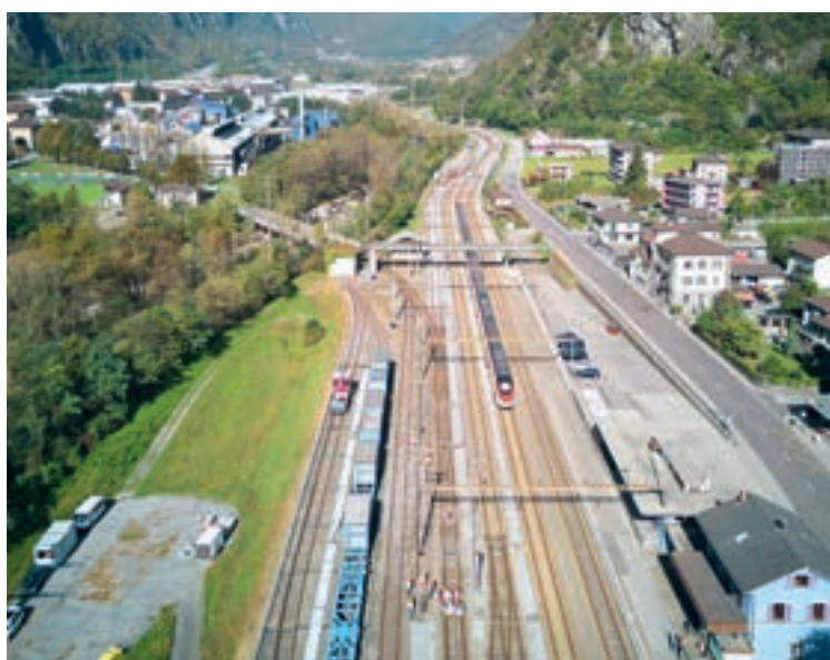
Accanto all'area dei lavori scorre il normale traffico ferroviario.
