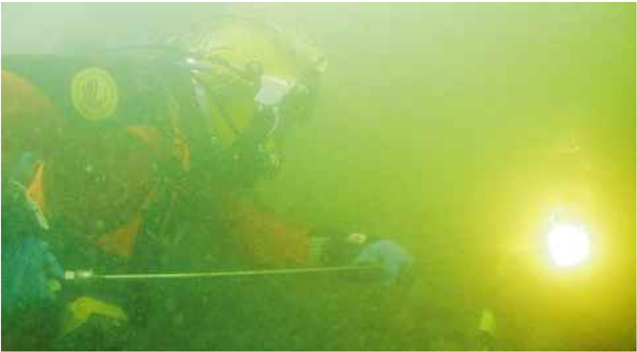
Saldatura subacquea. Foto: F. Hattan, Hergiswil
