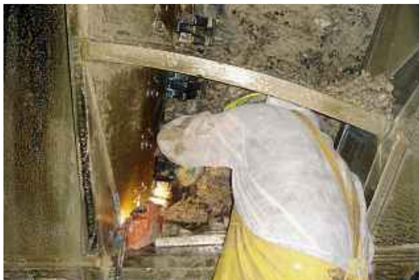
cambio di utensile sulla fresa rotante è un compito pesante da svolgere in condizioni di sovrappressione e di clima caldo-umido nella camera di lavoro di una fresa per lo scavo di gallerie.
