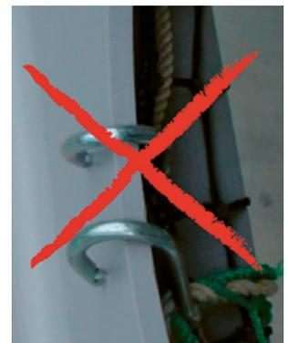
**3** Offene Karabinerhaken verlieren massiv an Tragfähigkeit. Grundsätzlich keine Karabinerhaken für die Netzmontage verwenden!
