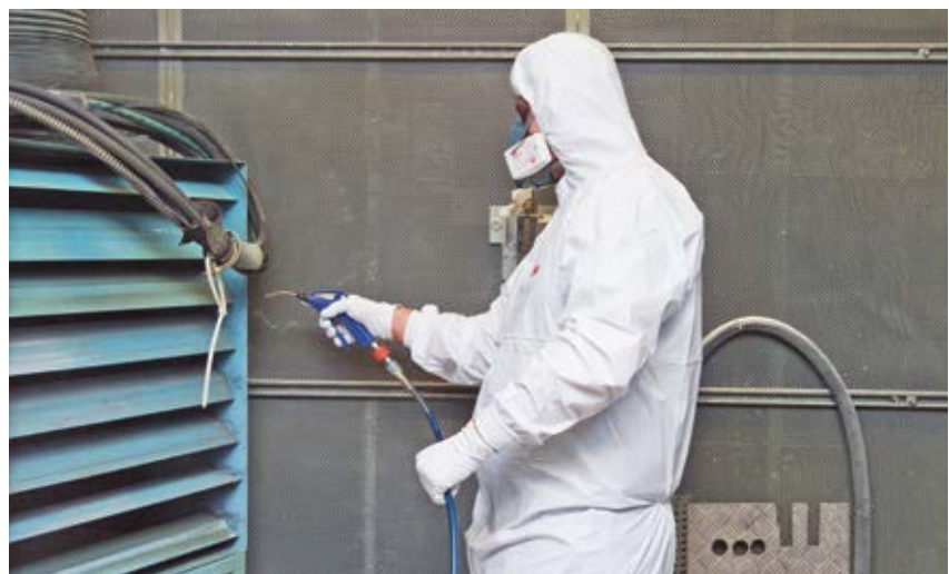
Fig. 6: pour le nettoyage, l'air comprimé n'est autorisé que si aucune autre solution n'est techniquement possible et si le travail est réalisé avec une aspiration continue de la cabine.
