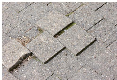
3 Exemple d'irrégularité dans le sol constituant un risque de chutes et faux pas.
