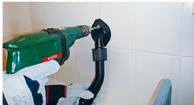
Perçage d'un carreau
