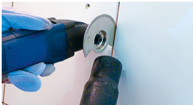
Remplacement d'un carreau
