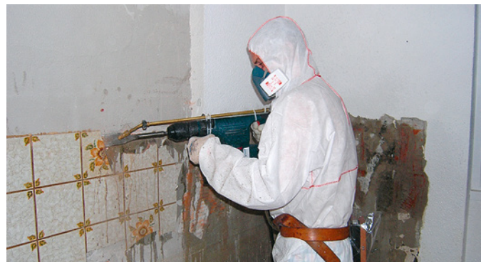
Enlever les carreaux par voie humide (< 5 m 2 )
