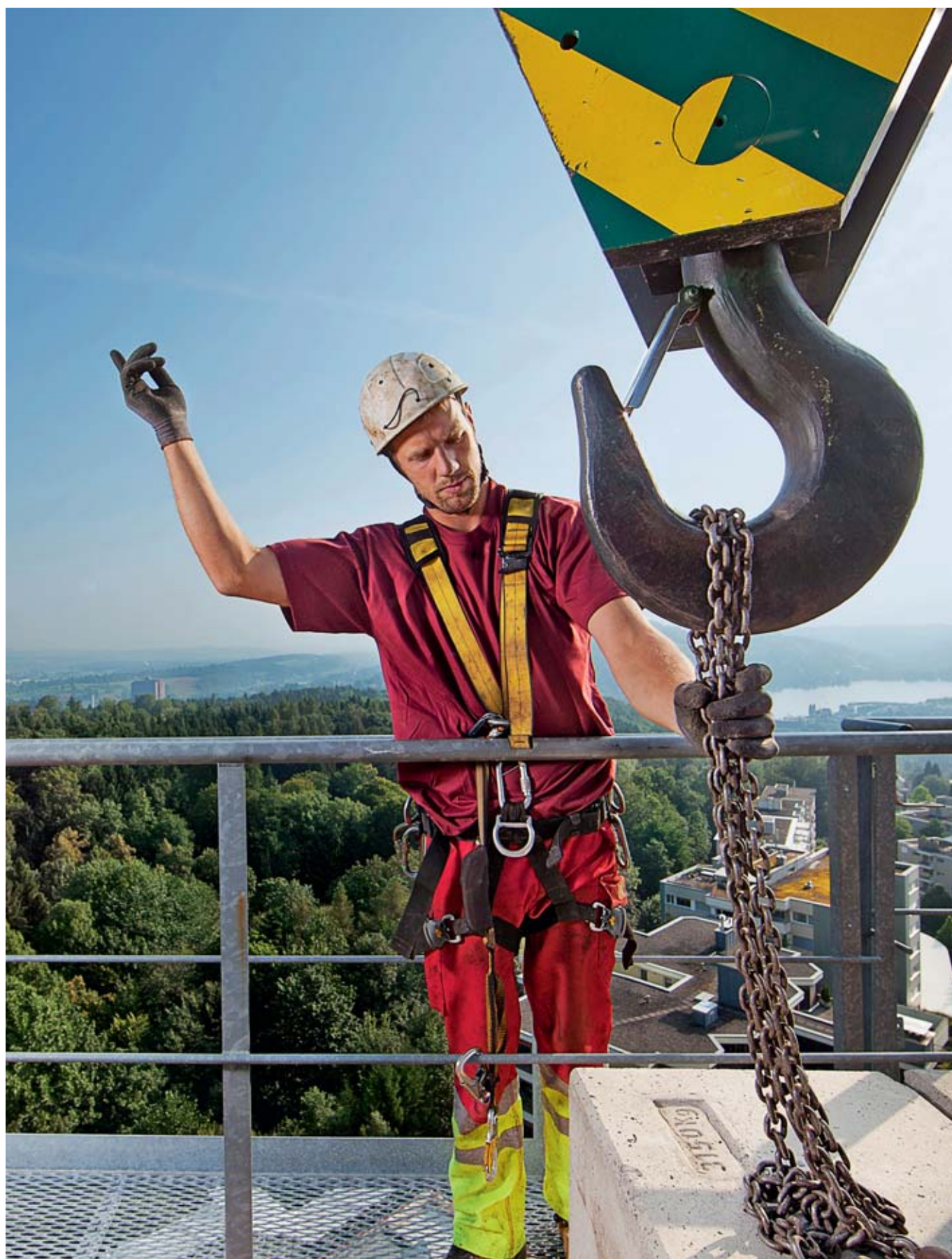
03 // Fiducia: con un cenno, Marco segnala al gruista a terra di sollevare il carico.
