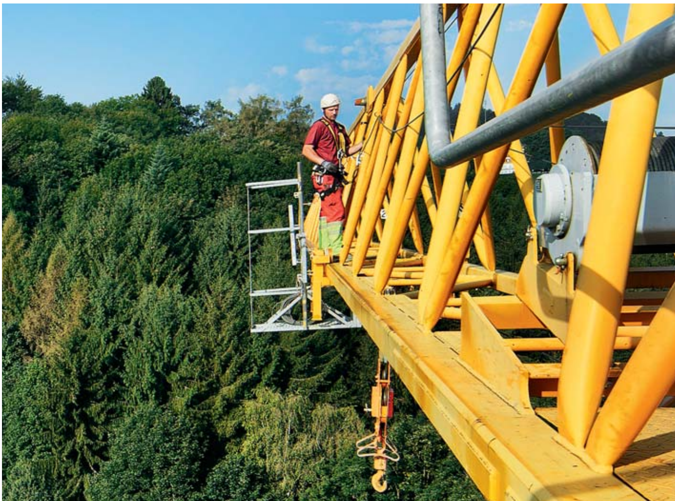
01 // Un lavoro per chi non soffre di vertigini. A 40 metri da terra, il braccio della gru può oscillare anche di un metro quando c'è vento.
