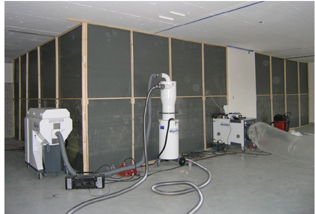
3 Separatori di polveri e apparecchio per il mantenimento della depressione
