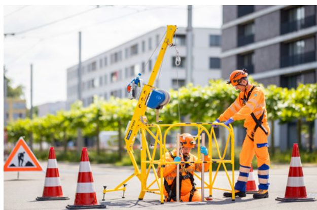
1 e 2 Zone di lavoro sbarrate e ben segnalate
