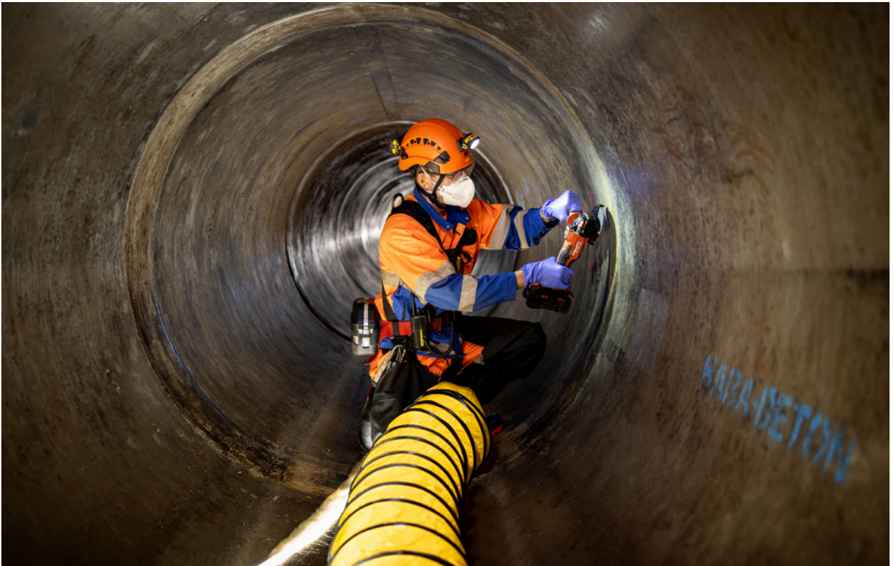
11 Lavori di smerigliatura con i dispositivi di protezione individuale necessari
