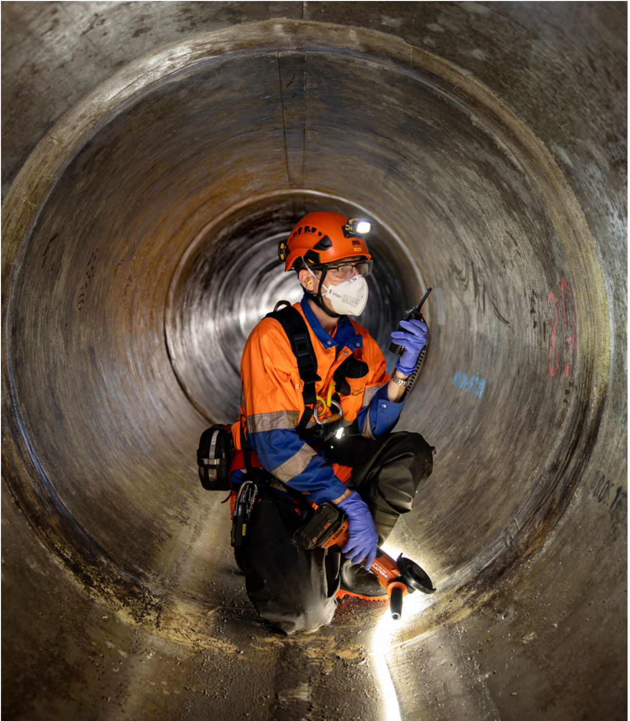
13 Con una ricetrasmittente si garantisce la comunicazione con la persona da sorvegliare durante la sua permanenza nella canalizzazione.
