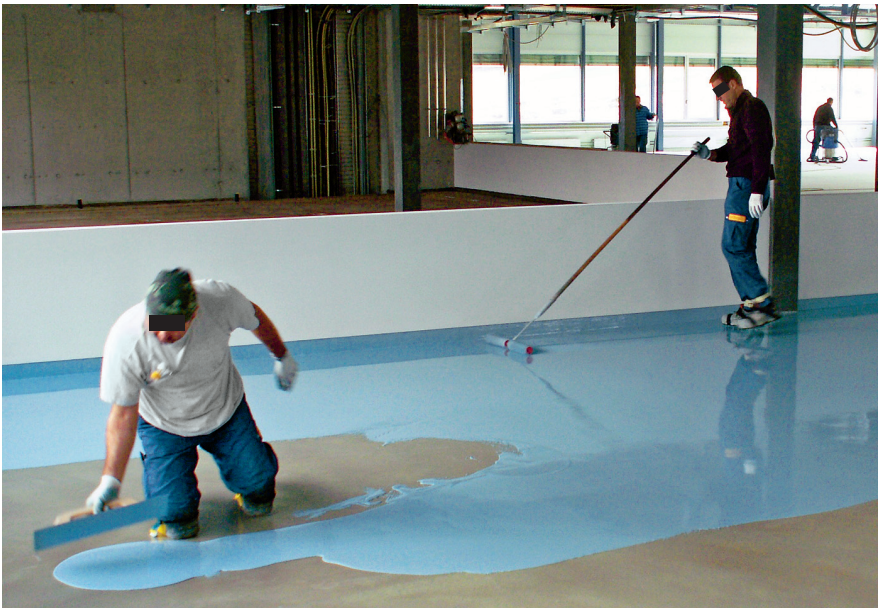
Abb. 2 Arbeit mit Epoxidharz im Baugewerbe
