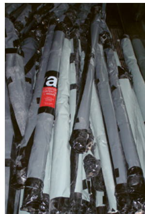
5 Tubi avvolti nella plastica pronti per essere inviati alla ditta di bonifica
