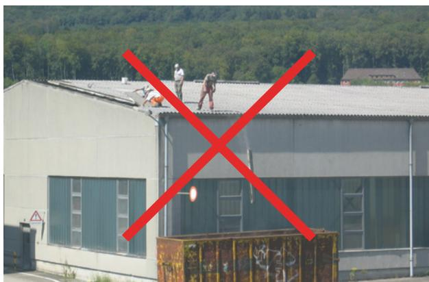
**1 e 2** Comportamento gravemente negligente durante i lavori sulle superfici del tetto in fibrocemento e in prossimità di elementi traslucidi.
