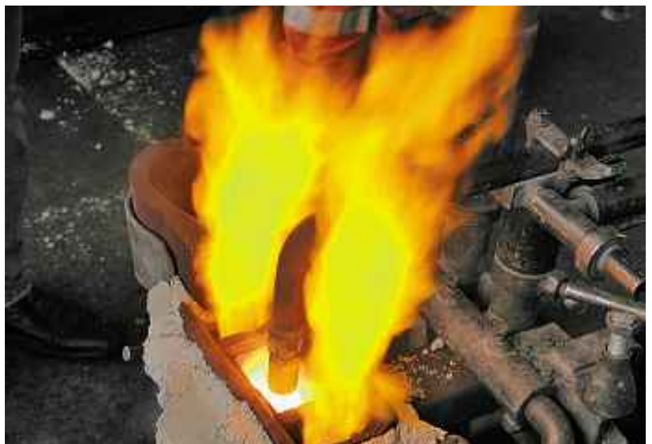
Figura 1: saldatura alluminotermica di binari ferroviari
