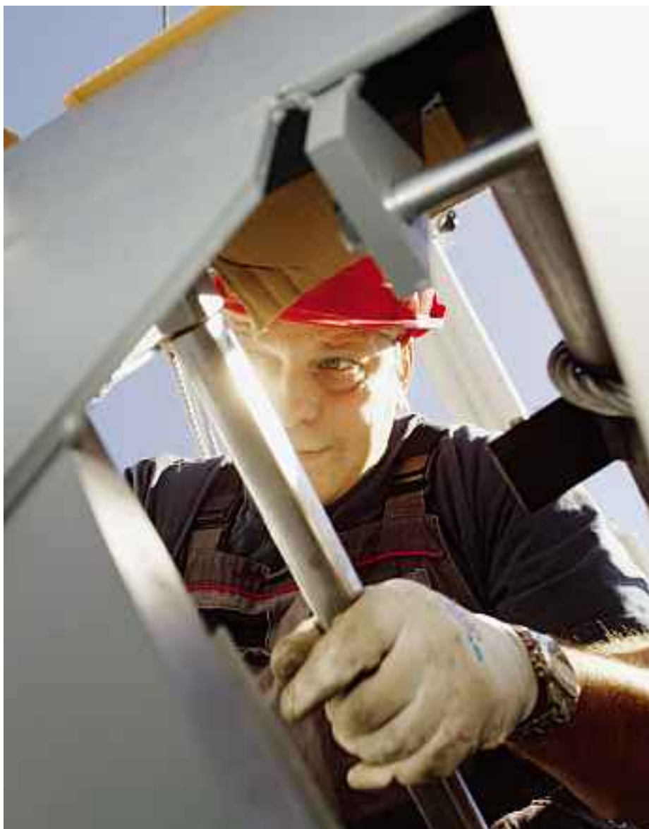
Importante durante la manutenzione: pianificazione dei lavori e controllo finale.
