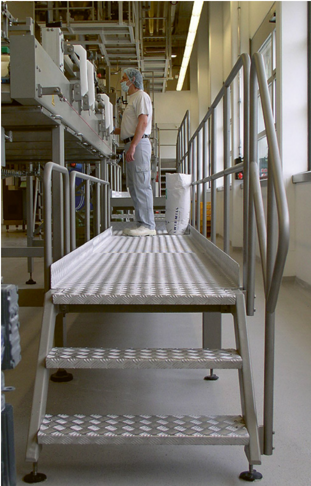
4 La piattaforma di controllo lungo l'impianto di trasformazione è protetta su entrambi i lati da un parapetto. In questo caso i parapetti sono necessari perché l'altezza di caduta è superiore a 500 mm.
