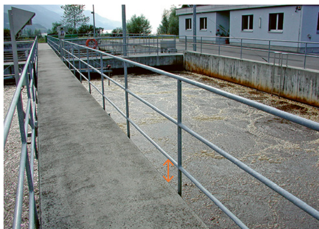
22 Le esigenze aziendali (rimozione della neve) non permettono di applicare dei bordi di arresto al piede lungo questa passerella, situata all'interno di un impianto di depurazione. In compenso è stato montato un corrente intermedio in più. In questo caso è consentita una distanza massima di 300 mm tra la superficie di calpestio e il corrente intermedio più basso.
