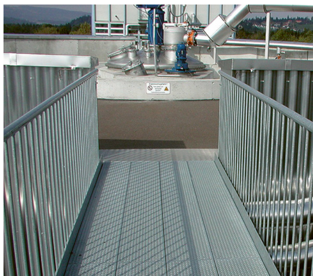
18 Parapetto con barre di riempimento verticali. La distanza fra una barra e l'altra non supera i 180 mm.
