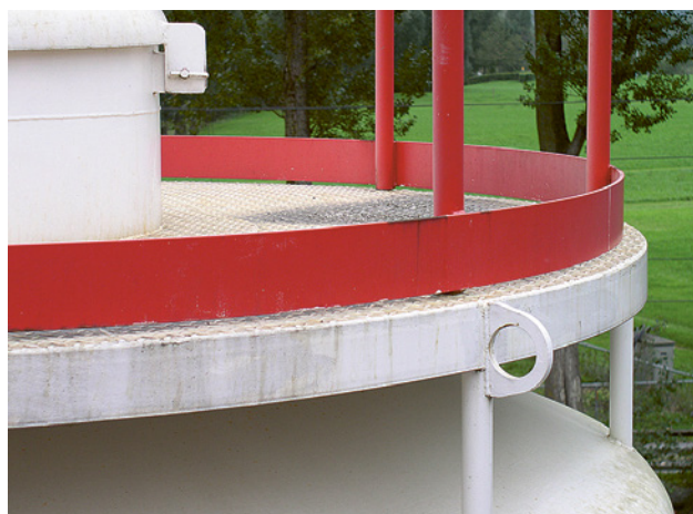
21 Lo spazio vuoto fra la superficie di calpestio e il bordo di arresto al piede permette all'acqua piovana e all'acqua di scioglimento di scorrere. Lo spazio vuoto non supera i 12mm.
