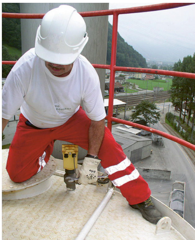
19 Il bordo di arresto al piede (altezza minima 100mm) impedisce che gli addetti alla manutenzione possano scivolare sotto il parapetto o che eventuali oggetti possano cadere e ferire le persone in sosta o in transito nell'area sottostante.
