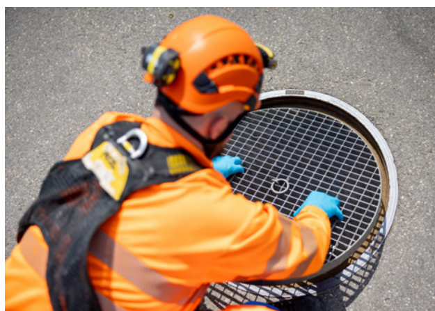
3 Un couvercle de grille empêche les chutes de hauteur.
