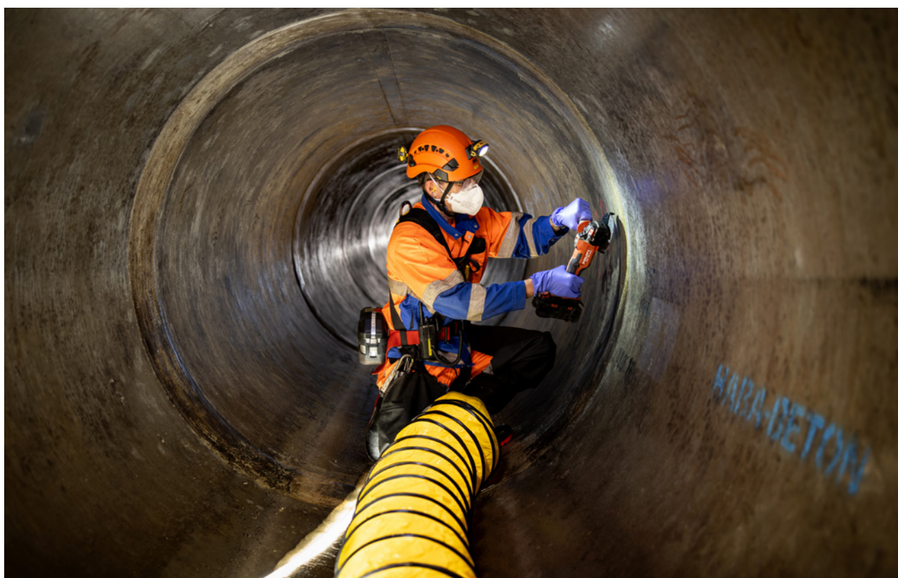
11 Travaux de meulage effectués avec les équipements de protection individuelle nécessaires
