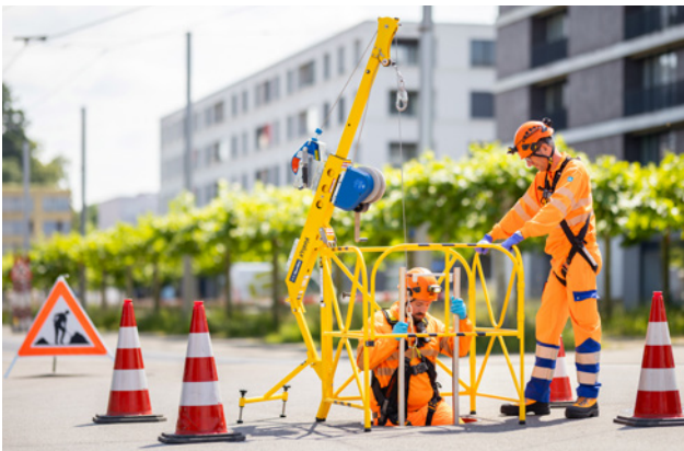
5 et 6 Les antichutes à rappel automatique avec treuil de sauvetage offrent un niveau de sécurité élevé. Ils bloquent automatiquement les chutes et permettent un sauvetage rapide.
