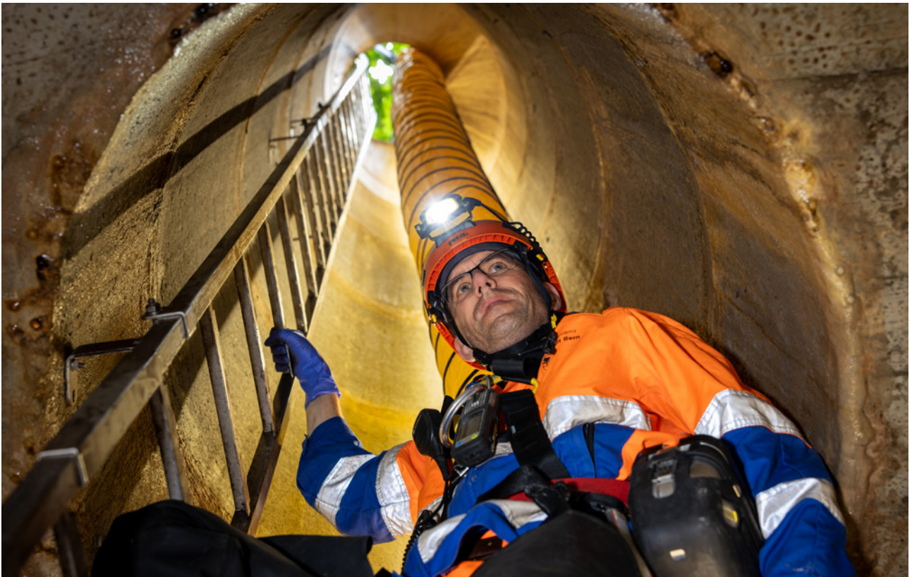
10 Mesure continue de l'atmosphère avec un détecteur de gaz mobile
