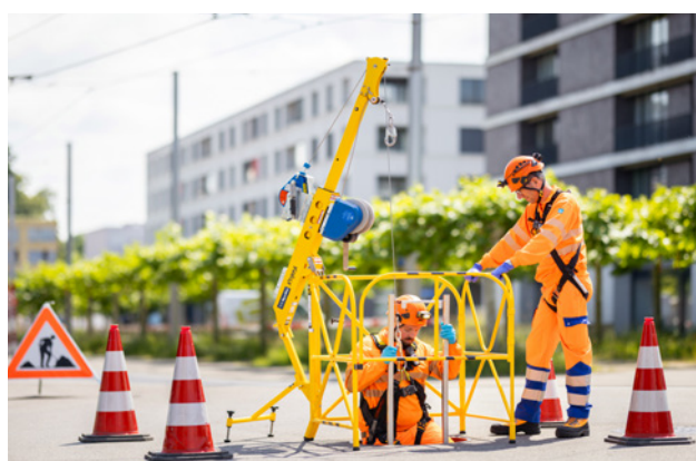
1 et 2 Délimitation et signalisation de la zone de travail
