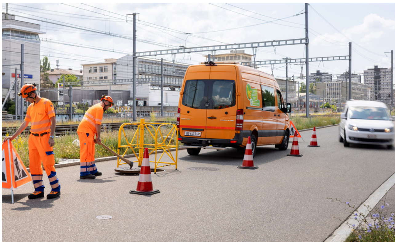
14 Sécuriser la zone de travail vis-à-vis du trafic.
