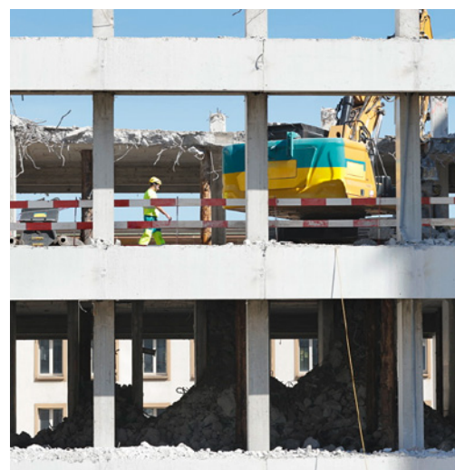
5 Nei punti a rischio di caduta dall'alto è stata installata una protezione laterale.
