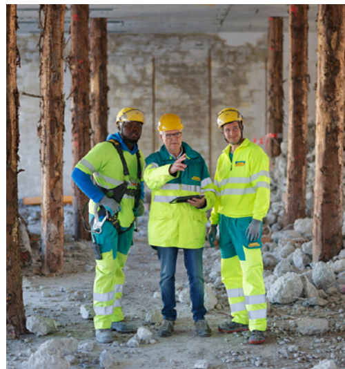
1 Preparazione dei lavori con l'aiuto del piano di demolizione (piano di sicurezza e di tutela della salute)
