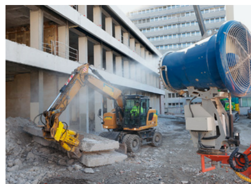
6 La formazione di polvere deve essere contenuta con adeguate misure, ad es. nebulizzazione di acqua sull'apparecchio demolitore, irrorazione con acqua.
