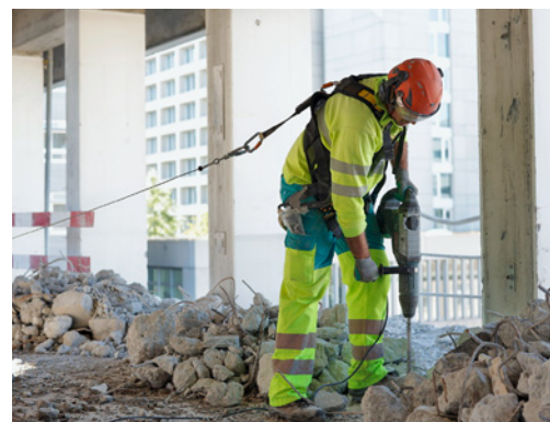
4 L'operaio indossa DPI anticaduta durante il montaggio della protezione laterale.
